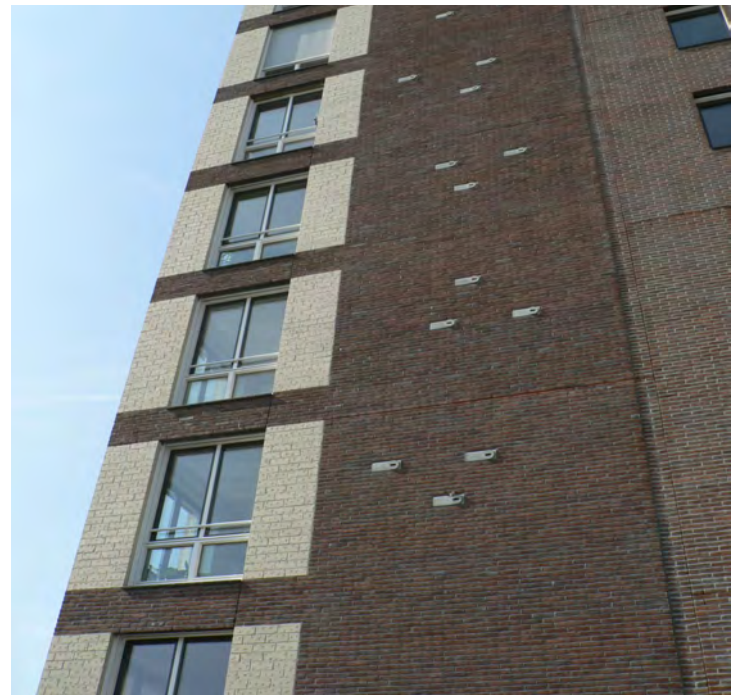
Meerdere neststenen in een gevel
