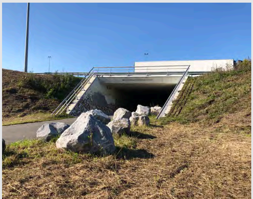
Voorbeeld van een faunapassage in een onderdoorgang
