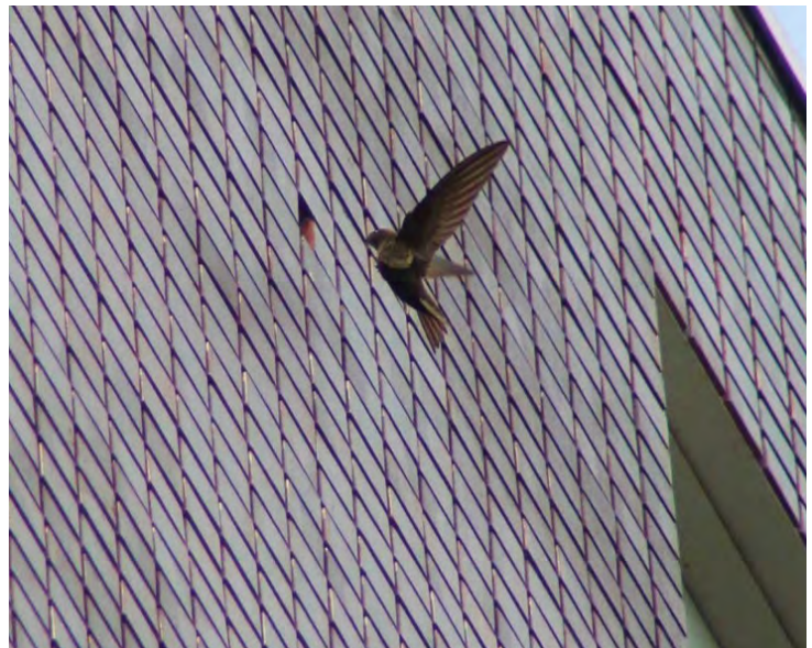
Gierzwaluwsteen weggewerkt in gevel
